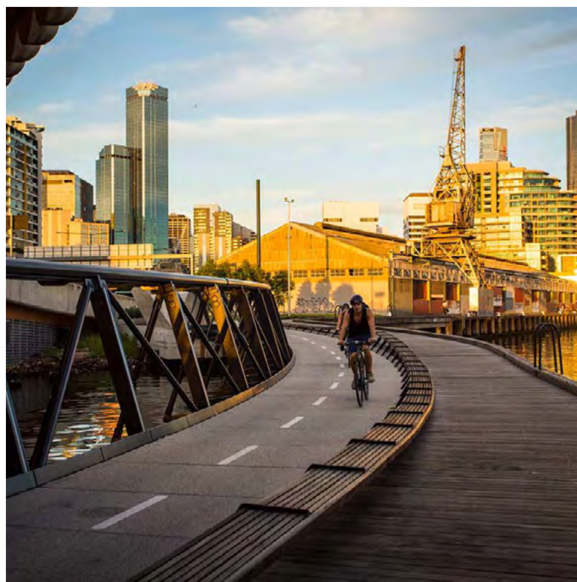
Проект моста Джима Стайнса Oculus Landscape Architecture, COX Architecture, Aurecon Мельбурн, Австралия 2010-2014 Площадь территории - 0,3 га Заказчик: Муниципалитет Мельбурна Стоимость: $ 12 млн.
