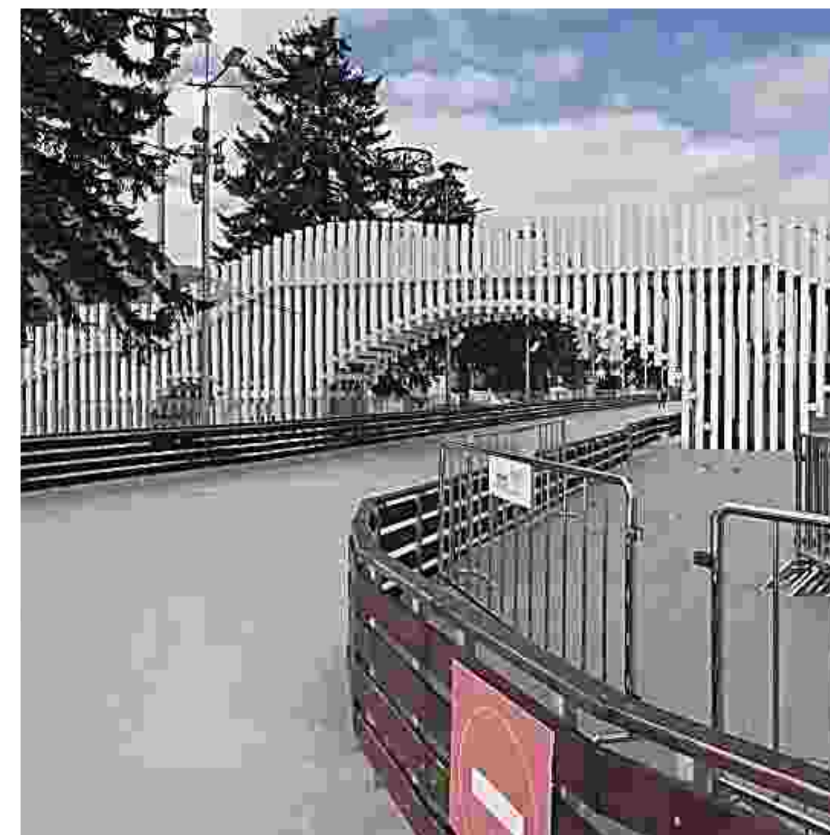
Пешеходный мост и каток на ВДНХ Москва, Россия 2014 Авторы: Бюро AI-Architects Заказчик: ООО "Русский лед Девелопмент" Длина моста — 100 м
